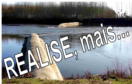
Seuil à échancrure du Fresne visible les 2/3 de l'année et générant des courants de 10 km/H...
