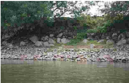
Berge enrochée en continu, avec des pierres de gros calibre en haut de rive
