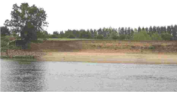
Erosion spectaculaire de la rive de la Pierre de Drain en amont de Champtoceaux malgré des enrochements de protection. Cette érosion a été bien sûr accentuée par l'accélération du courant et le surcreusement du chenal de navigation qui ont sapé les berges....
