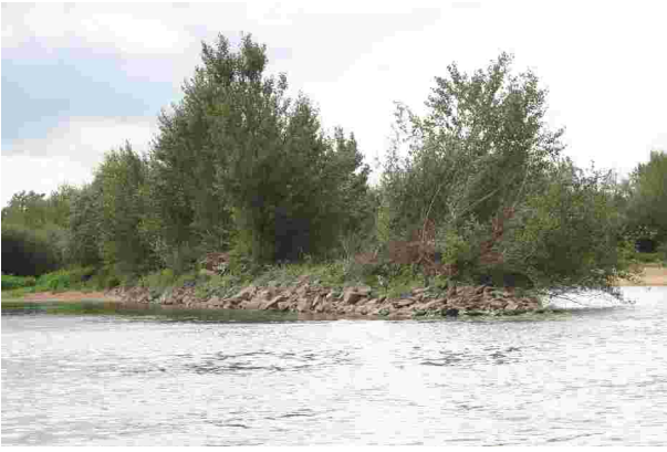
Epi végétalisé par des peupliers noirs freinant le courant de crue et susceptible de le dévier, de créer des érosions ou des dépôts de sable inopportuns.
