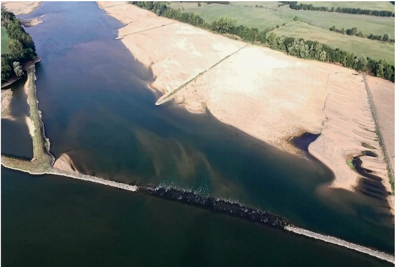
Photo aérienne de la chevrette du grand bras de Varades (ancien chenal de navigation) avec sa chevrette à profil concave (CLD - Octobre 2016- 220 m 3 /s – photo GC)
