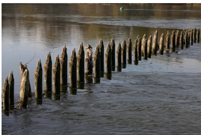
Représentation virtuelle d'un duit de pieux composée avec des pieux déchaussés d'anciens épis (donc pointus !).
