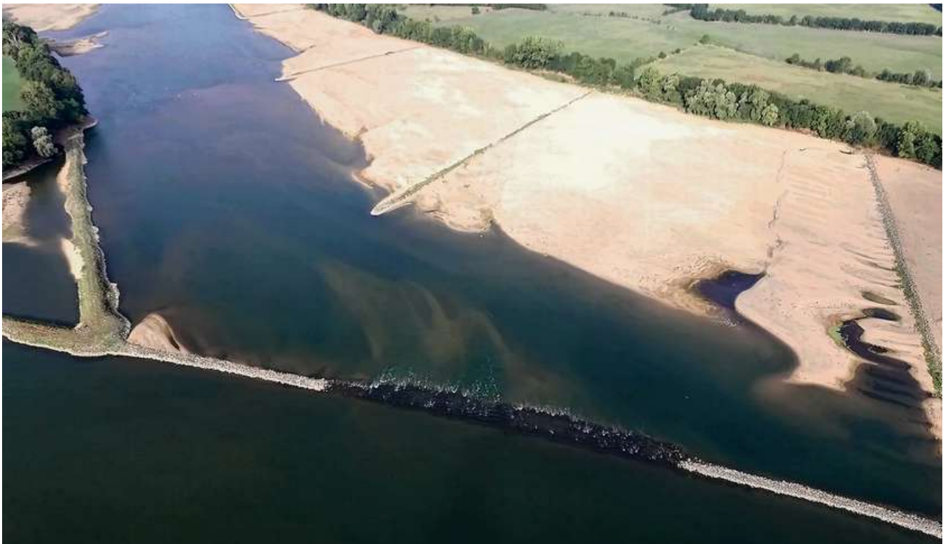
Photo aérienne de la chevrette du grand bras de Varades (ancien chenal de navigation) avec sa chevrette à profil concave (CLD - Octobre 2016- 220 m 3 /s – photo GC)
