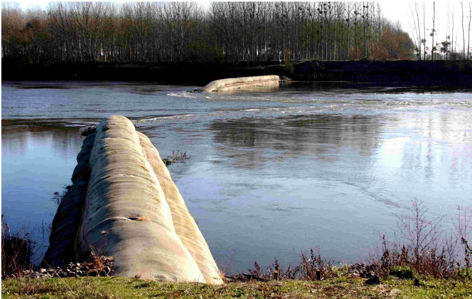
*L'un des deux seuils expérimentaux du Fresne-sur-Loire avec le violent courant généré dans l'échancrure (10 km/h). La structure en géotextile rempli de sable est visible les 2/3 de l'année.*
