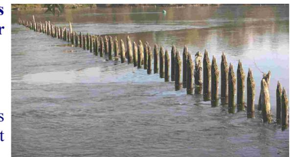
Image virtuelle d'un « duit filtrant » à l'étiage.
