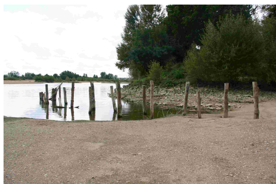
Vue de la tête de l'île protégée sommairement après une forte érosion et de la rive après le second seuil rive gauche...
