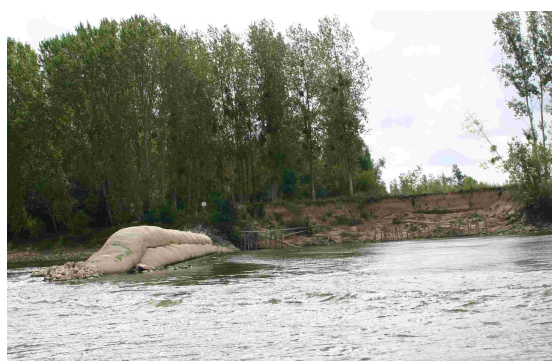
Vue de la tête de l'île protégée sommairement après une forte érosion et de la rive après le second seuil rive gauche...
