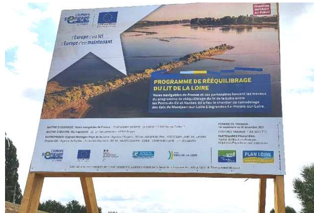
Panneau d'information officiel marquant le début des travaux du rééquilibrage du lit de la Loire aux abords du chantier (7/09/2021)
