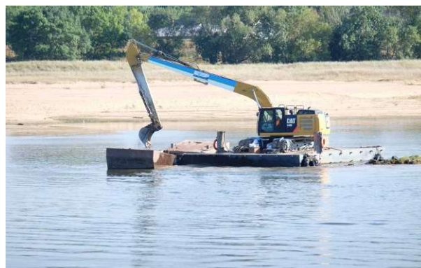
Derniers travaux par voie fluviale sur l'épi n°26 en face du Fresne juste après l'arrêt définitif du chantier décidé à cause de la montée des eaux. (7/10/2021- Ph. CLD)
