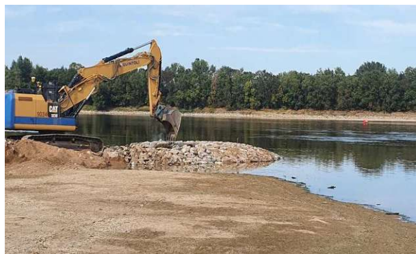
Musoir constitué à l'extrémité raccourcie de l'épi n° 2 (6/09/21- Ph. VNF)
