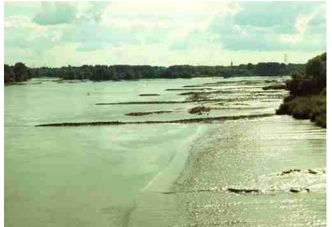
Vue du pont vers l'aval : le réseau d'épis en rive droite pouvant être réutilisé pour ancrer la bordure du chenal resserré ; au fond à gauche, le bras de l'île Héron...
