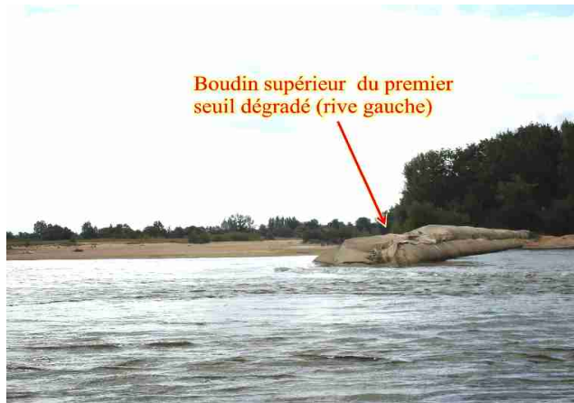
Vue de l'épi gauche du premier seuil dont le boudin supérieur se dégrade cinq années après sa réalisation (coût des deux seuils : 3 M d'euro)...
